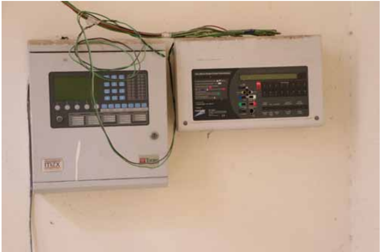
لوحتي إنذار خاصة بمبنى البرامج الجديدة
